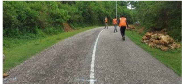
Gambar 4. 2 Tingkat kerusakan keriting (Sumber: Direktorat Jenderal Bina Marga, 1990).
