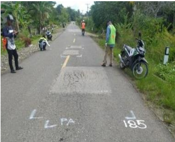
Gambar 4. 7 Tingkat kerusakan tambalan (Sumber: Direktorat Jenderal Bina Marga, 1990).
