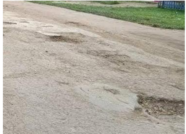
Gambar 4. 8 Tingkat kerusakan lubang (Sumber: Direktorat Jenderal Bina Marga, 1990).
