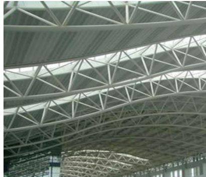
Gambar 7 Struktur Space Frame
